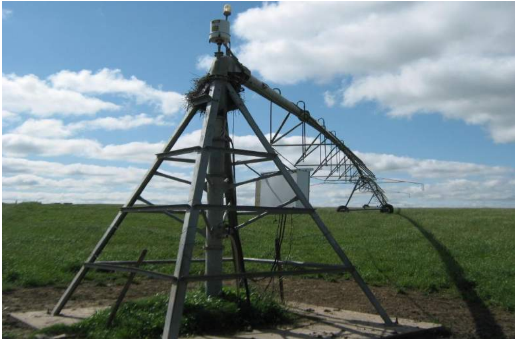
Figura 1 - Base do pivô com sistema de tomada de água e caixa de controle central
