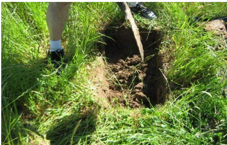
Figura 5 – Início da abertura das trincheiras
